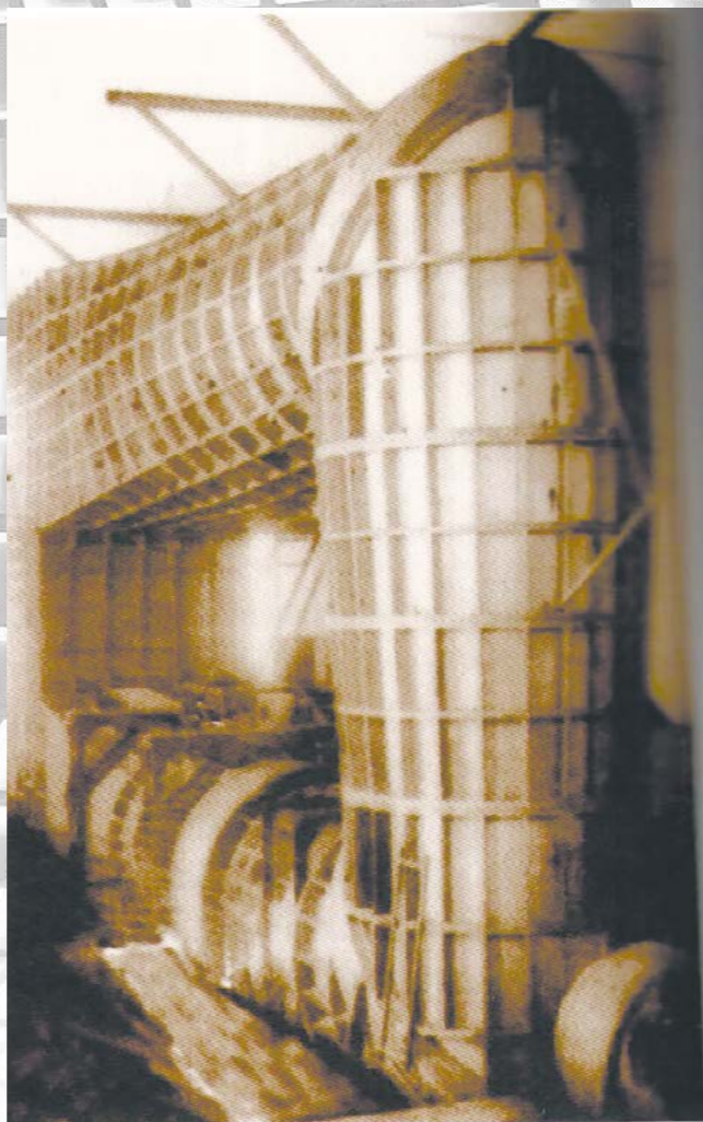
Общий вид трубы Т-201, установленной в Aviационном техникуме в 1942 году
